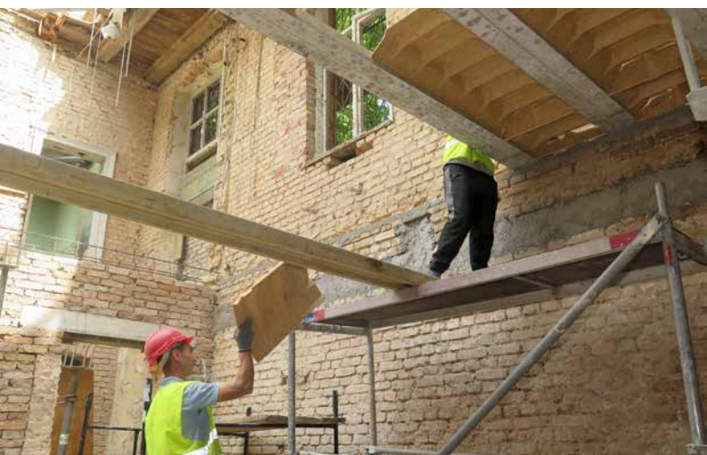
Wymiana stropu w budynku istniejącym
