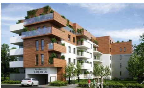
Budynek wielorodzinny, Bydgoszcz
