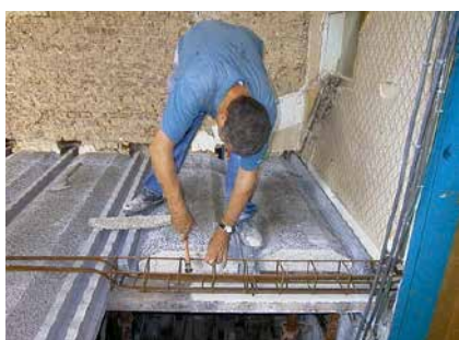
Oparcie na stalowym wymianie w przypadku wymiany stropu.
