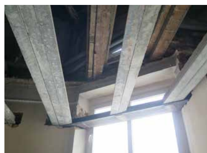
Oparcie na stalowym wymianie w przypadku wymiany stropu.
