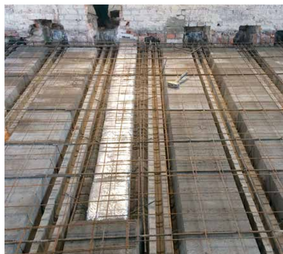
Ukrywanie instalacji w stropie
