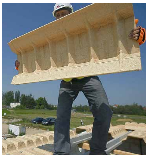
Lekki w montażu
